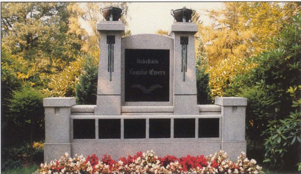
NACH ERFOLGTER RESTAURIERUNG
